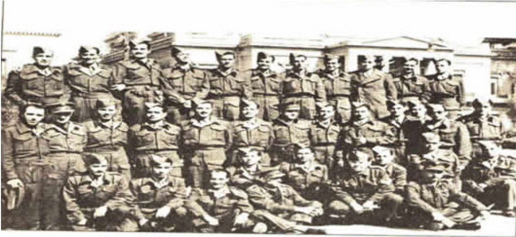
Από την ημέρα της Ορκωμοσίας του Συντάγματος Δωδεκανησίων
