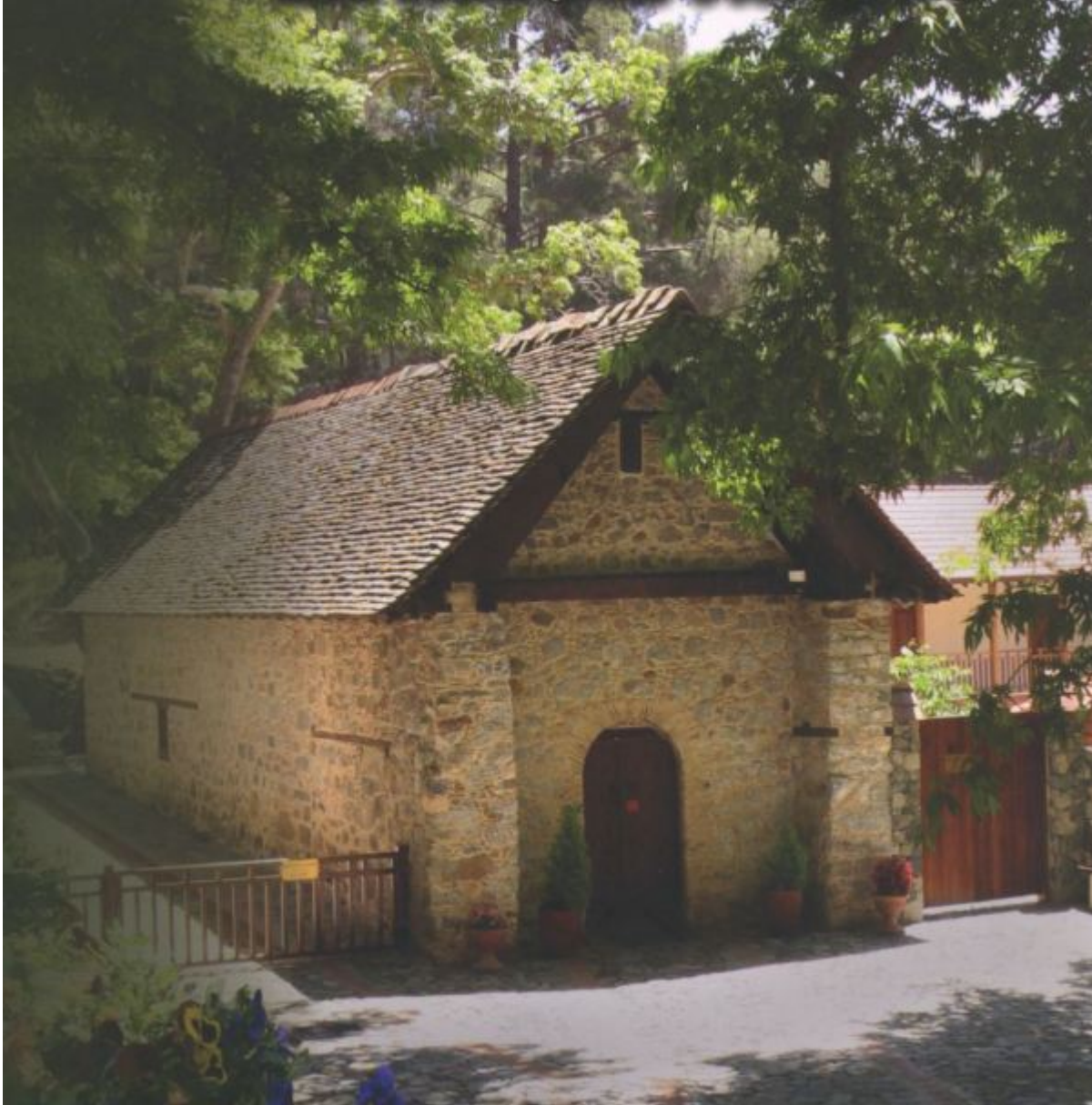
Εξωτερική άποψη του Καθολικού της Ιεράς Μονής Τιμίου Προδρόμου Μέσα Ποταμού
