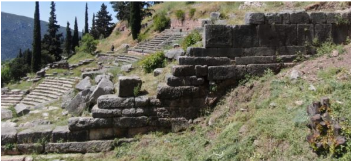
Βόρειο τμήμα του αναλήμματος
