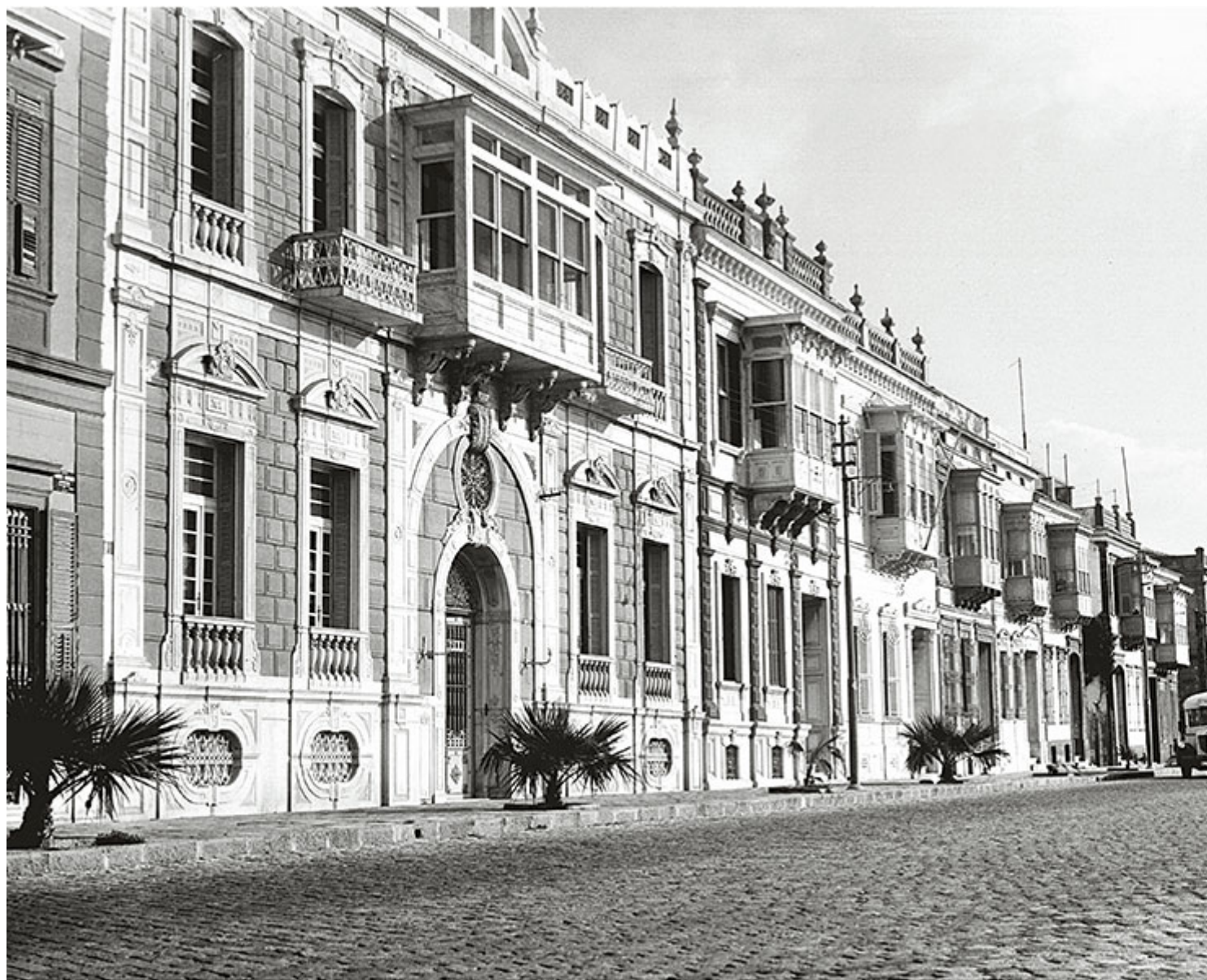
Το εικονιζόμενο τμήμα της προκυμαίας (πάνω η αρχιτεκτονική αποτύπωση του «μετώπου» των κτιρίων) δεν άλλαξε σχεδόν. Οι παλαιές διώροφες κατοικίες κατεδαφίστηκαν για να χτιστούν πολυκατοικίες. Φωτ. Cemal Yalkin
