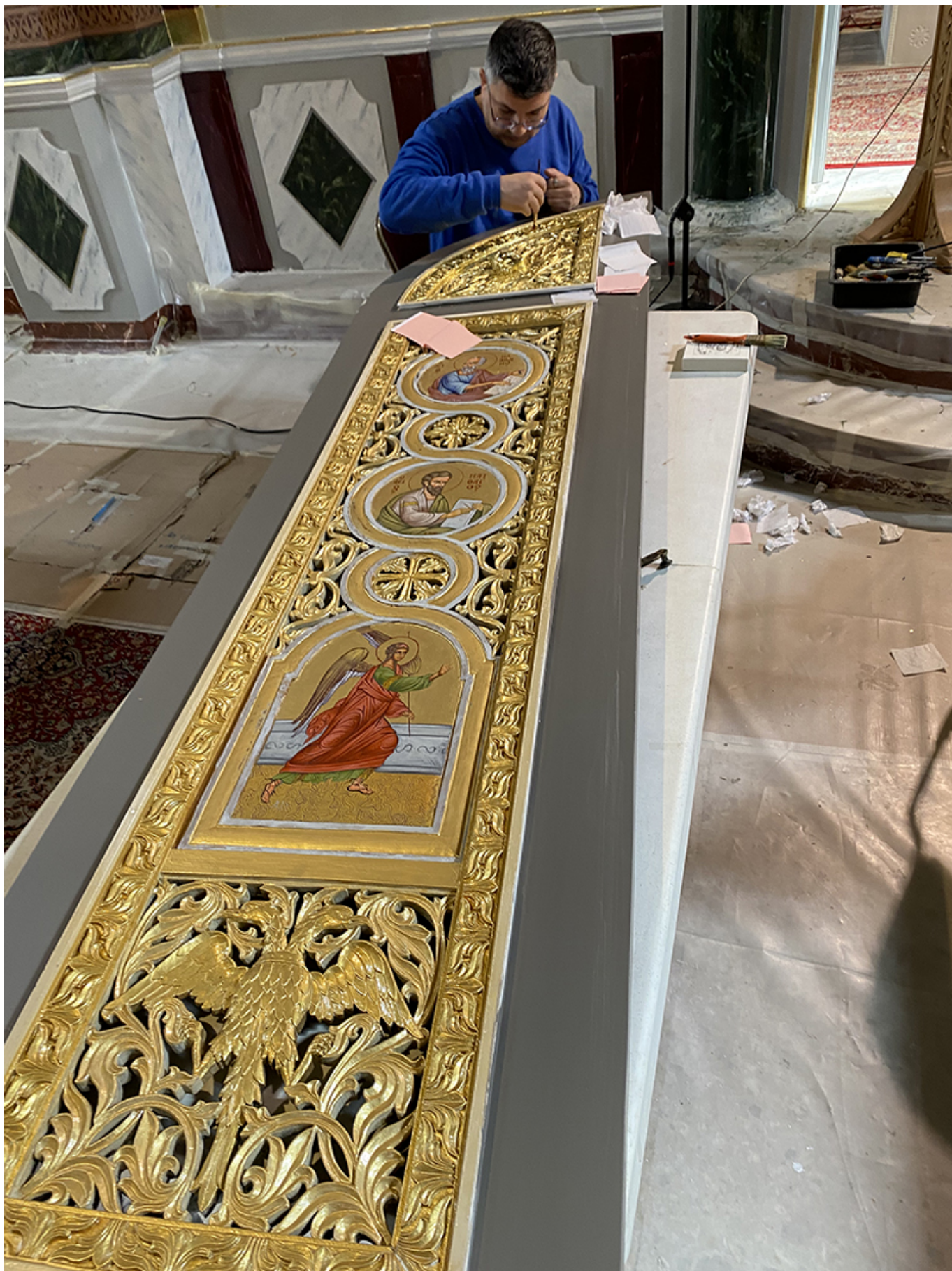
Εκτός όμως αυτών, εκτεταμένες ήταν και οι εργασίες για τον καθαρισμό, την
