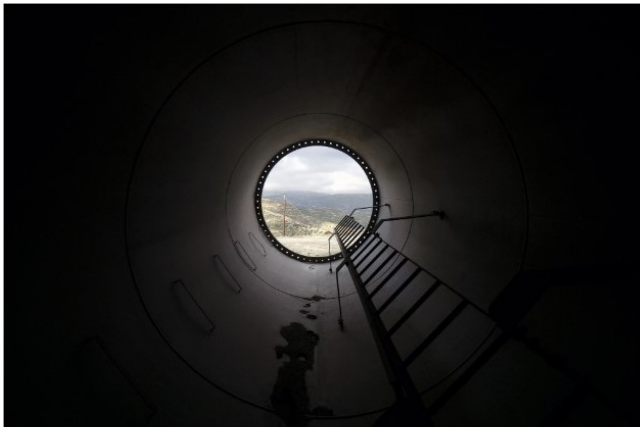
Τοποθετημένος στο έδαφος πια, ο πυλώνας μιας ανεμογεννήτριας «αποκαλύπτει» το εσωτερικό του. Φωτ. ΘΟΔΩΡΗΣ ΝΙΚΟΛΑΟΥ
