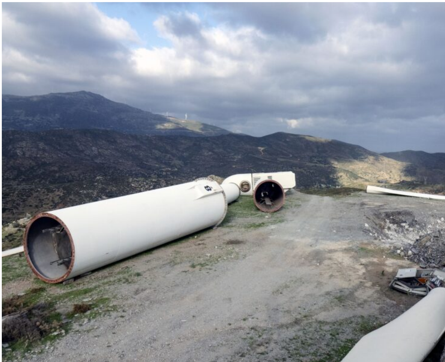
Σαν κομμάτια παιδικού παιχνιδιού, οι τεράστιες ανεμογεννήτριες κείτονται στην περιοχή του αιολικού πάρκου στο Καστρί που θα «αποσυρθούν». Φωτ. ΘΟΔΩΡΗΣ ΝΙΚΟΛΑΟΥ
