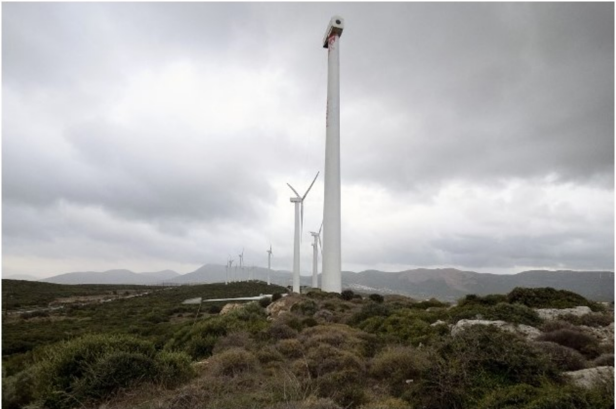
Σε παλαιά αιολικά πάρκα υπάρχουν χαλασμένες ανεμογεννήτριες που δεν έχουν επισκευαστεί. Δεξιά, ο Τάσος Μπαλτάς, πρόεδρος του Ορειβατικού Συλλόγου Χαλκίδας, δείχνει κομμάτια από περύγιο ανεμογεννήτριας. Φωτ. ΘΟΔΩΡΗΣ ΝΙΚΟΛΑΟΥ
