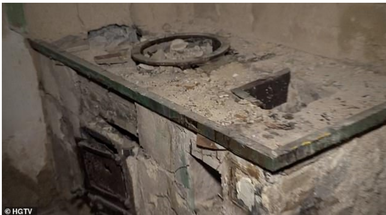
Το σπίτι δεν έχει ηλεκτρικό ρεύμα και η κουζίνα ήταν σε αυτή την κατάσταση
