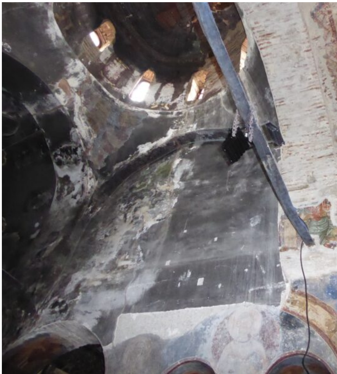
Το νότιο τμήμα του κεντρικού κλίτους πριν τη συντήρηση
