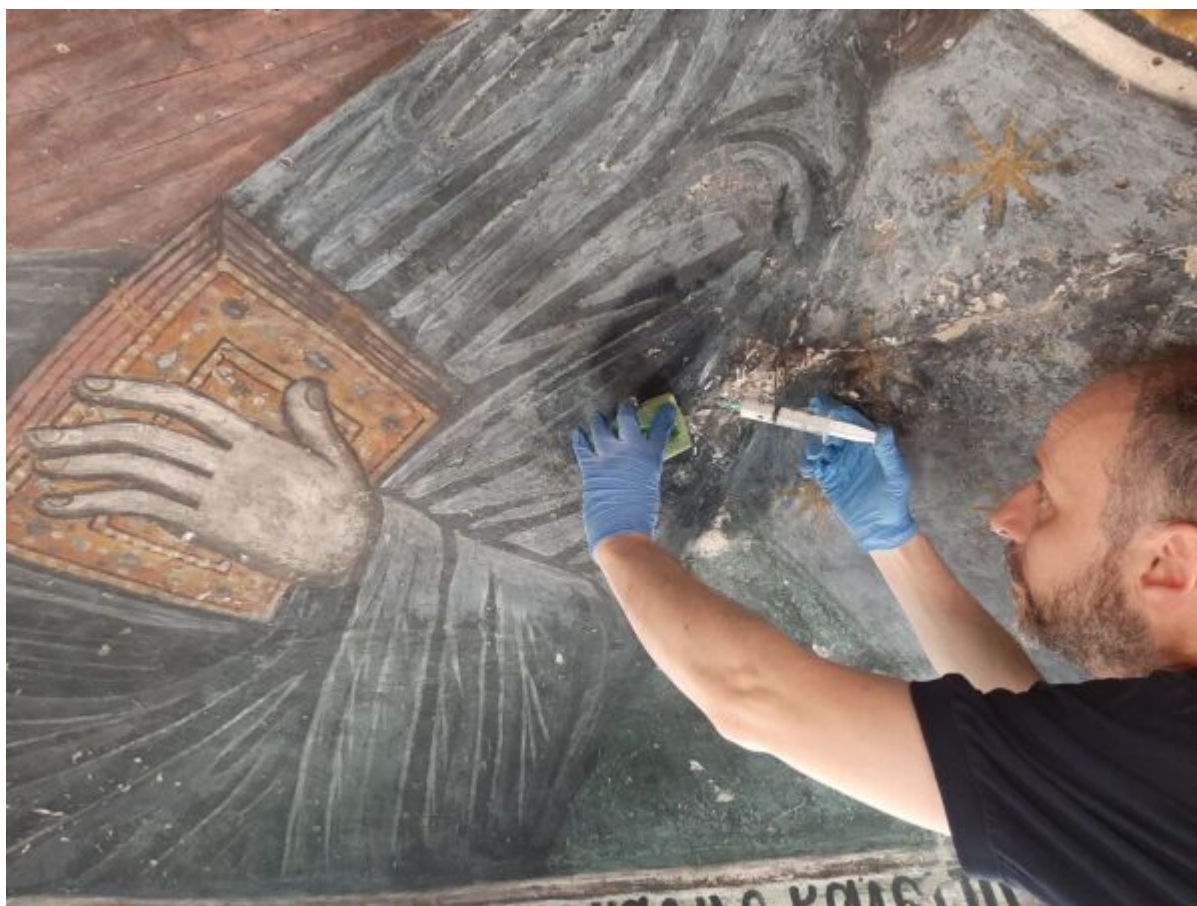
Κατά τις εργασίες στερέωσης στο υπόστρωμα της τοιχογραφίας
