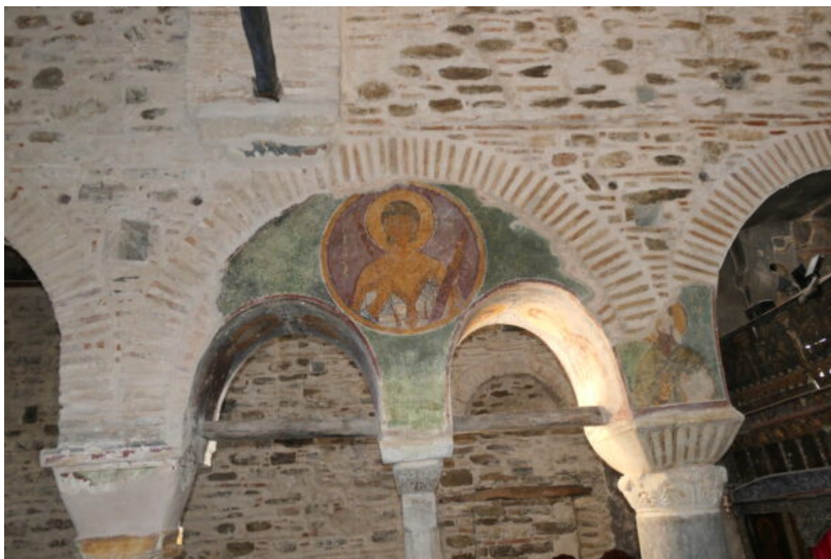
Το βόρειο τμήμα του κεντρικού κλίτους μετά τη συντήρηση
