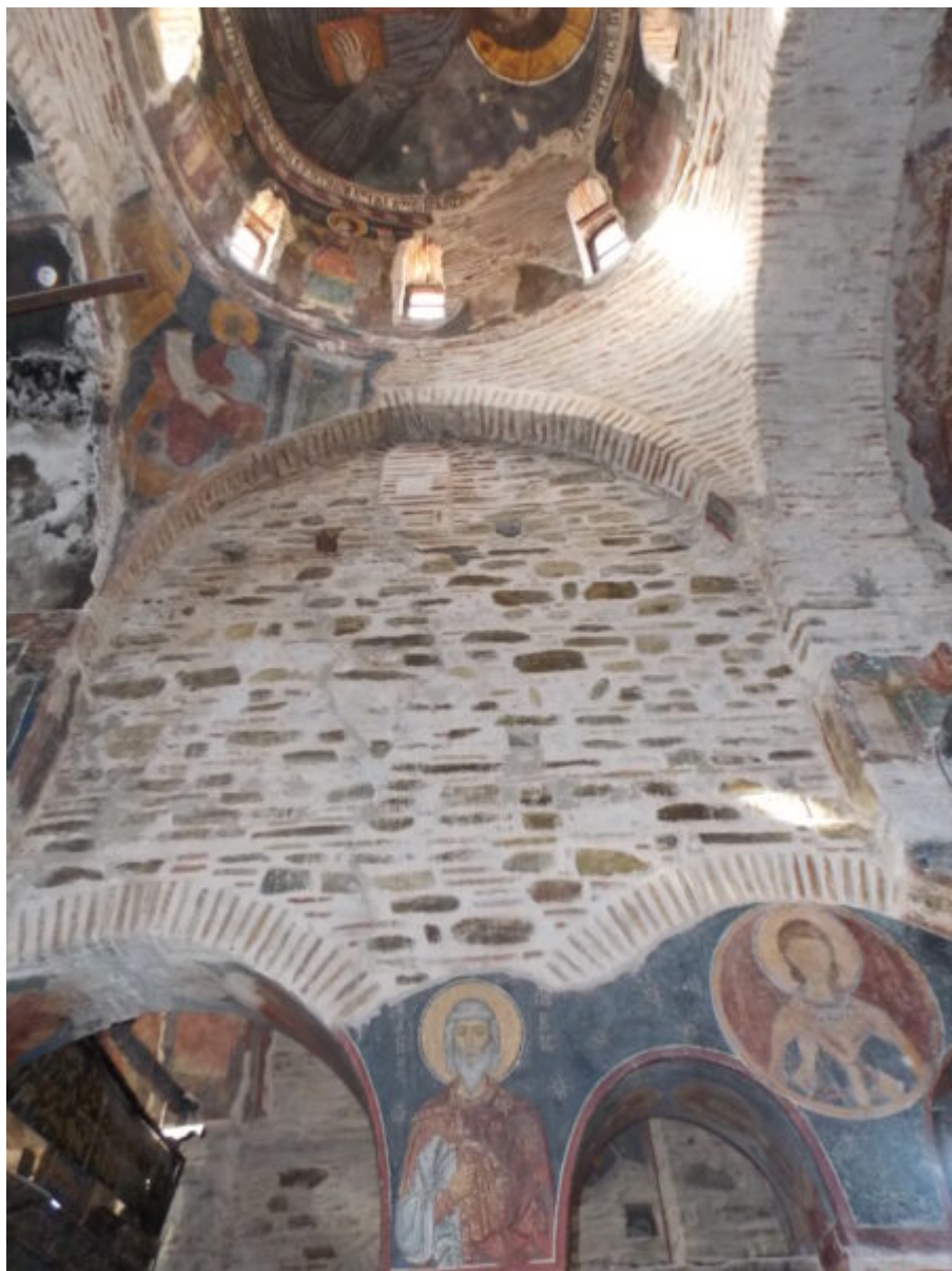
Το νότιο τμήμα του κεντρικού κλίτους μετά τη συντήρηση
