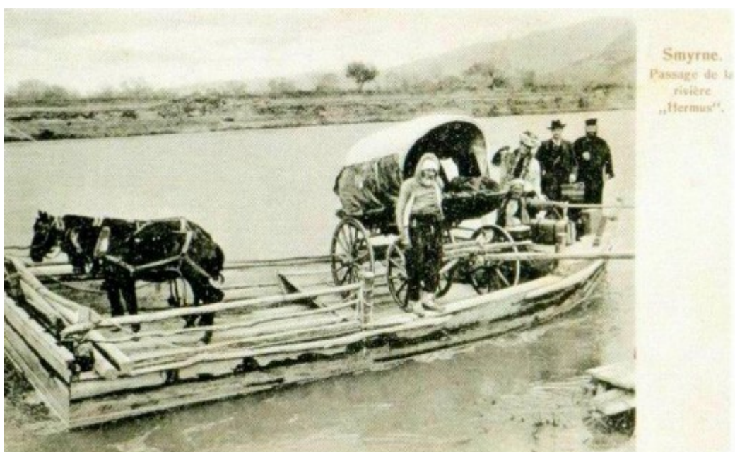
Πλωτή γέφυρα έξω από τη Σμύρνη.
