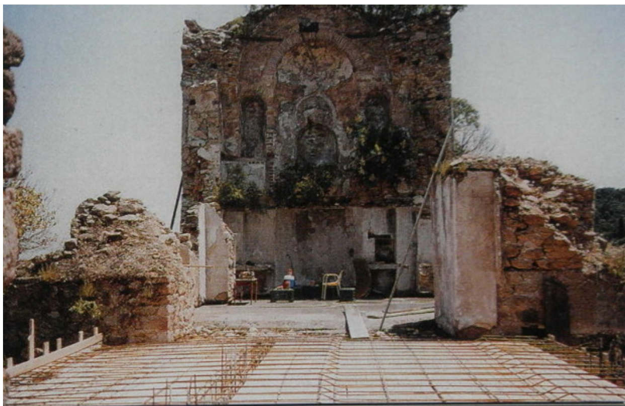
Προσπάθειες αποκατάστασης τοῦ Ναοῦ ἀπὸ τὸν μοναχὸ Εὐθύμιο. Ἐδῶ διακρίνεται ἡ πλάκα τοῦ πρώτου ὀρόφου τοῦ Ναοῦ.
