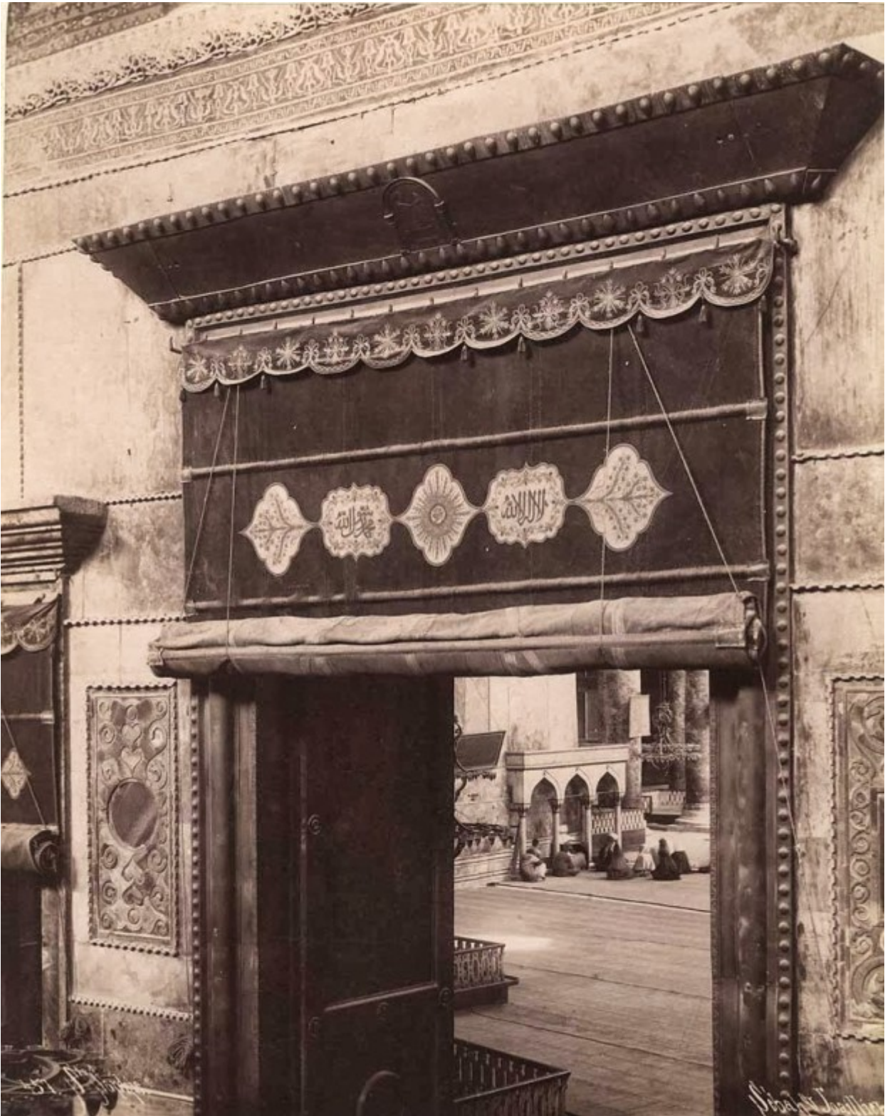
Δεξιά και αριστερά της κεντρικής Πύλης βυζαντινές ορθομαρμαρώσεις με ένθετα σχέδια.
