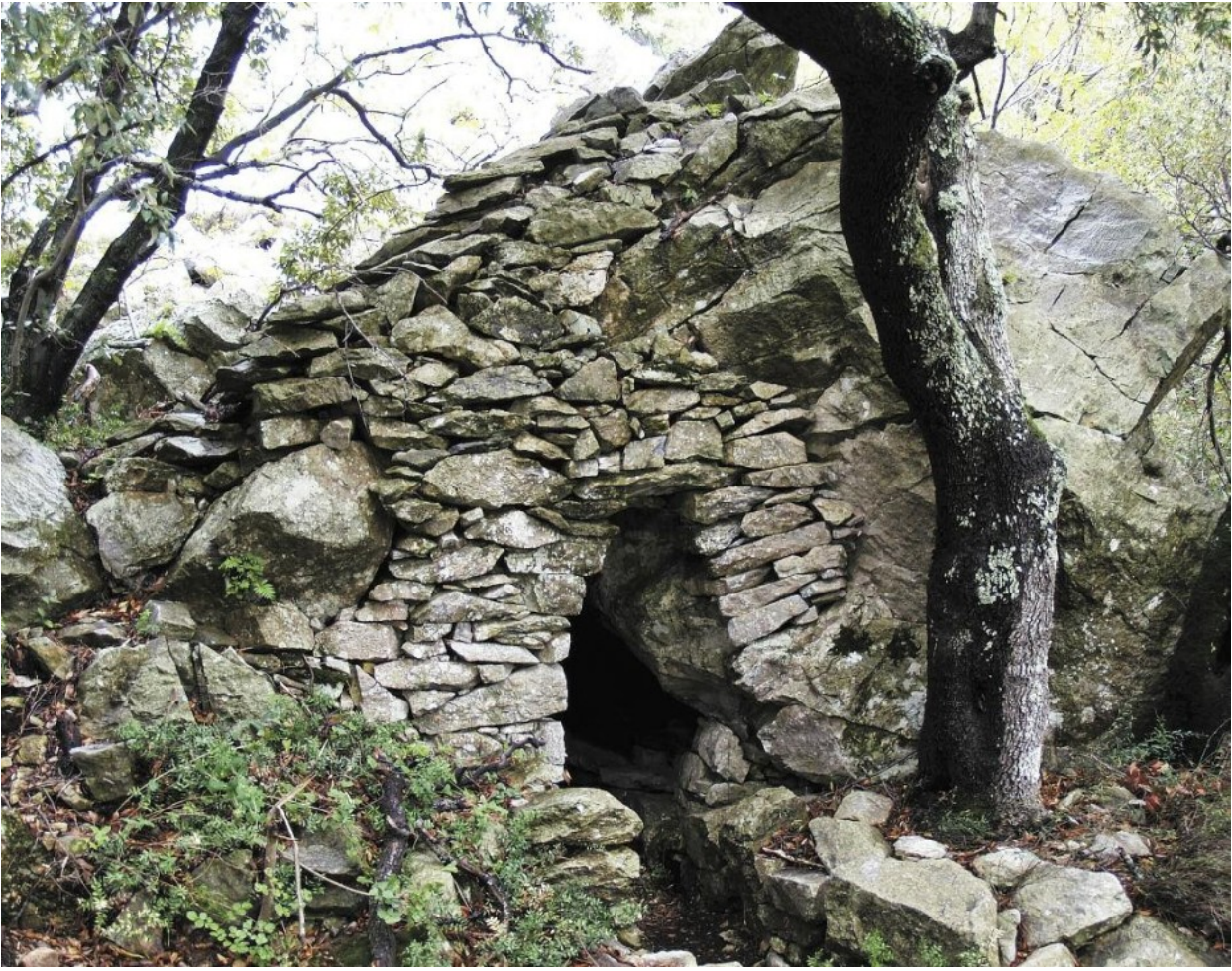
Ασκηταριό στα Καυσοκαλύβια κατασκευασμένο με τη συμπλήρωση ξηρολιθιάς στο φυσικό κοίλωμα, που προέκυψε από την τυχαία θέση ενός μεγάλου βράχου (τέλη 17ου αιώνα). Φωτ. Φαίδων Χατζηαντωνίου
