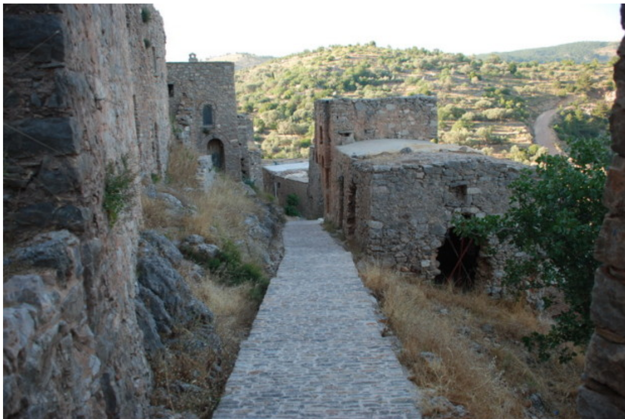
Γενική άποψη. Χίος, Ανάβατος, Δρόμος. (©Φωτογραφικό Αρχείο ΕΚΒΜΜ)
